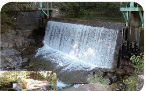
黒川の取水堰堤
