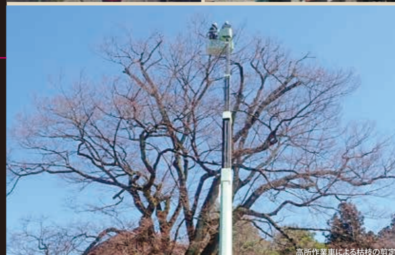
高所作業車による枯枝の剪定
