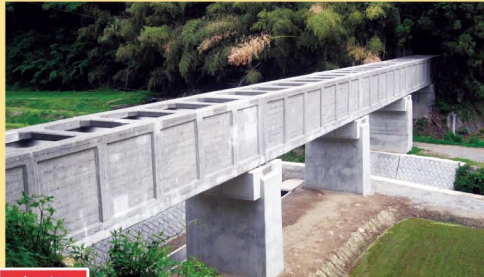
胡麻目沢水路橋
